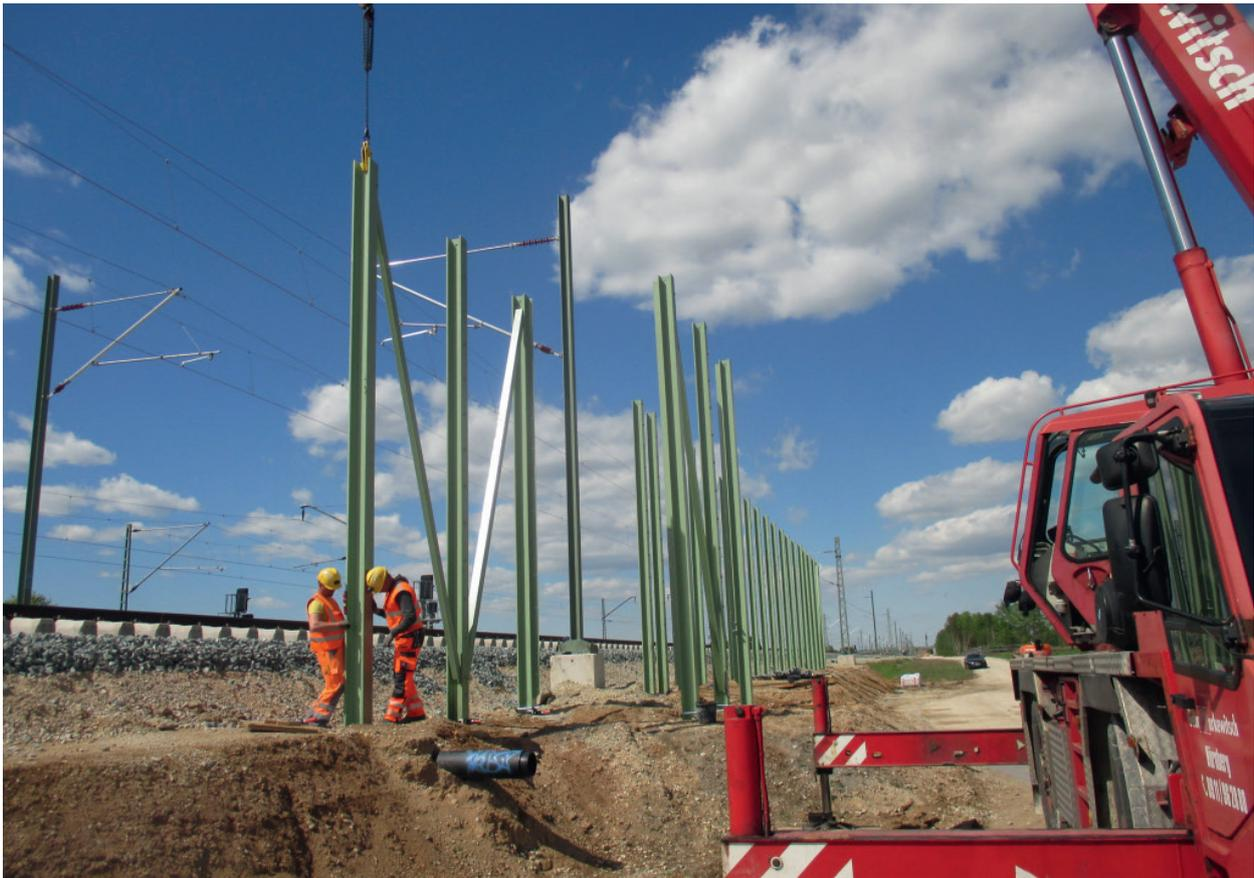
Bild 7: Einbau der Pfosten für einen Fledermausschutzzaun als Querungshilfe über die Bahnstrecke
